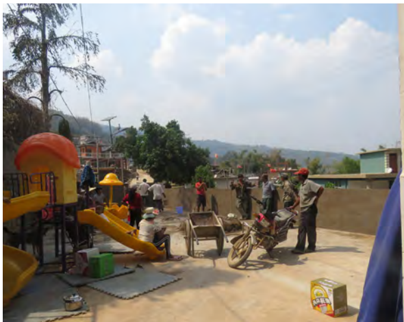
修建幼儿班围墙
